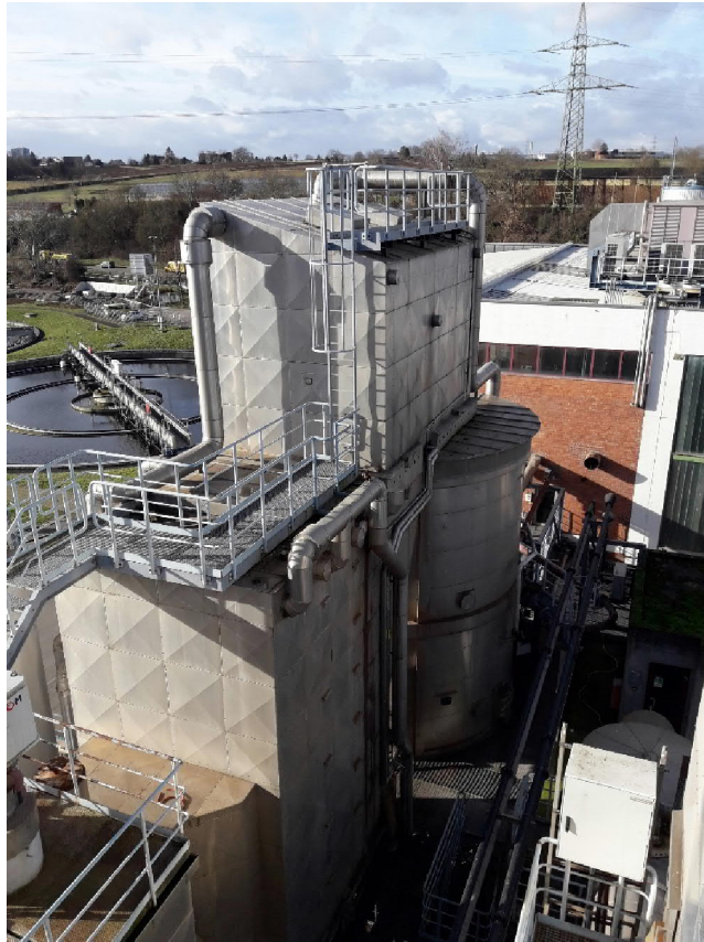
Abb. 13: Freibereich (Blickrichtung West)
