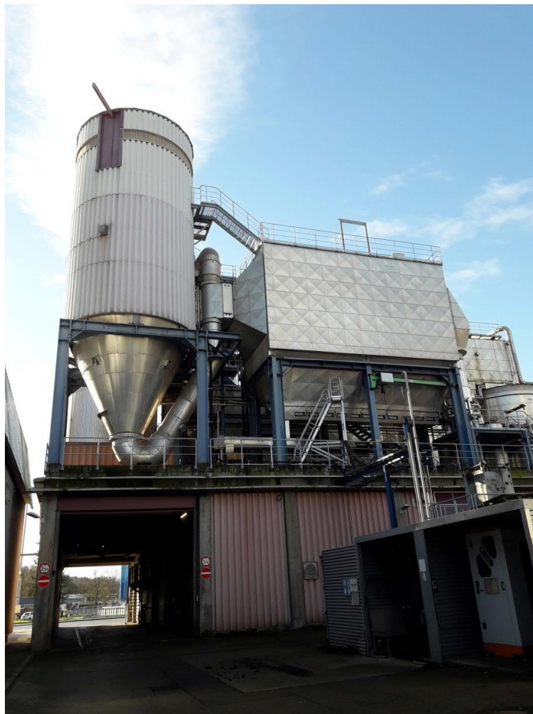
Abb. 11: Anbau 3 (Blickrichtung Süd bis Südwest)
