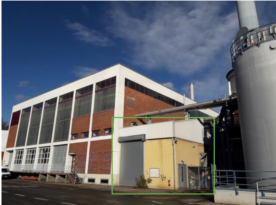
Abb. 9: Anbau 2 (Blickrichtung Nordwest)
