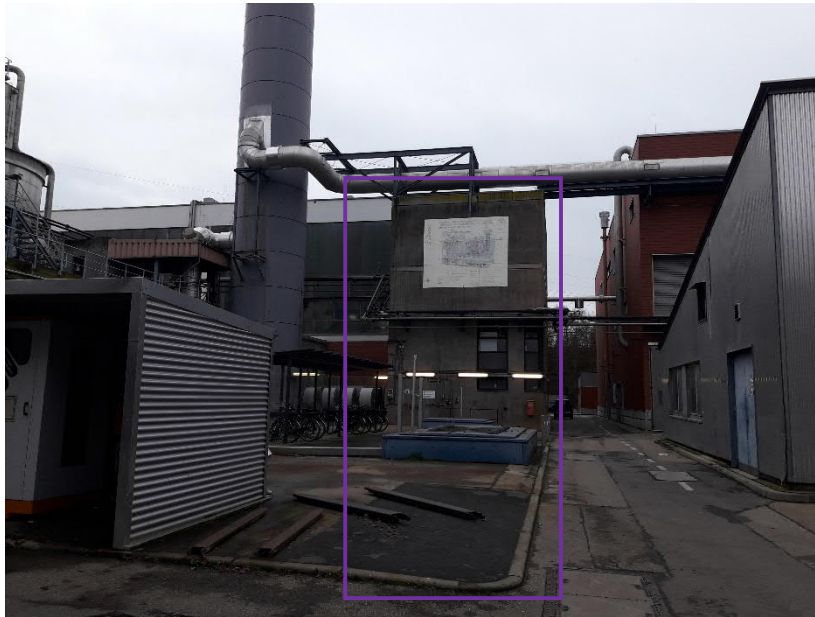
Abb. 7: Anbau 1 (Blickrichtung West bis Nordwest)
