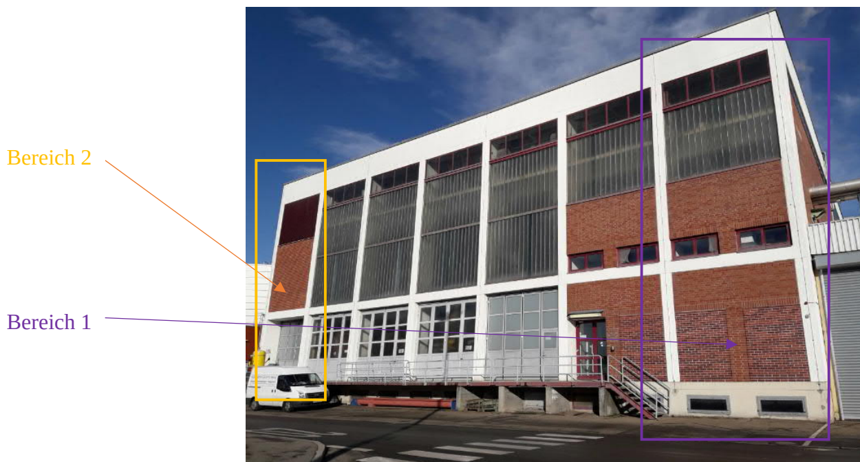
Abb. 1: Gebäude GOS 56 mit Markierung der Bereiche 1 und 2 (Blickrichtung Nord)
